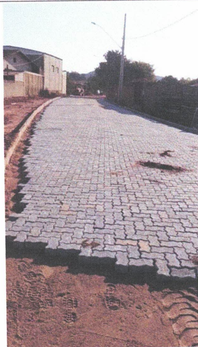
PAVIMENTAÇÃO EM PISO INTERTRAVADO
