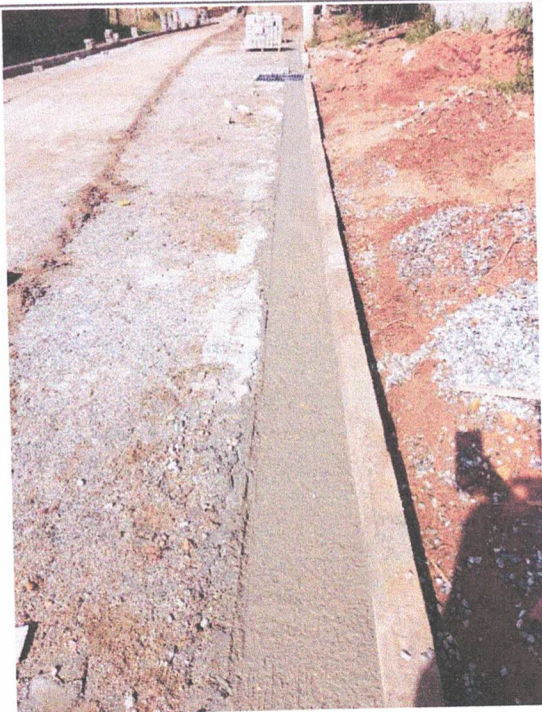
EXECUÇÃO DE SARJETA DE CONCRETO
