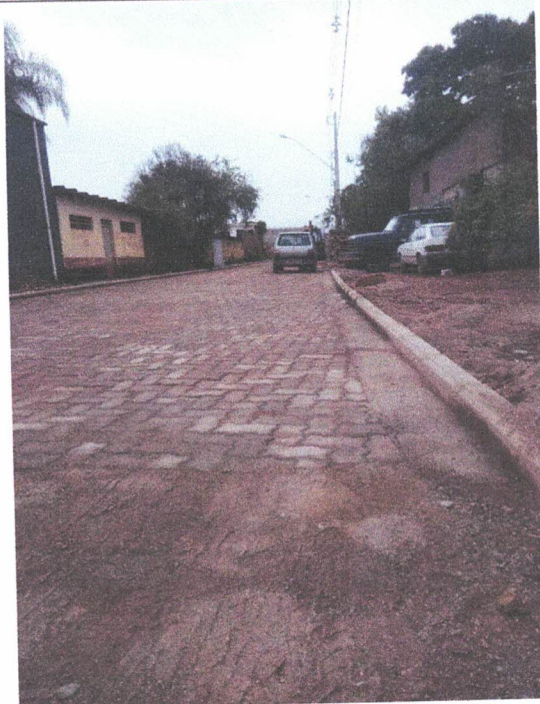
EXECUÇÃO DE PISO INTERTRAVDO
