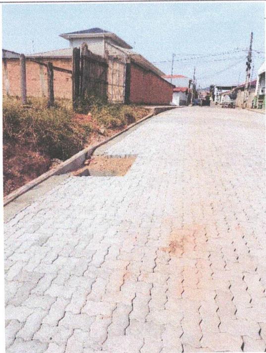
PAVIMENTAÇÃO EM PISO INTERTRAVADO
