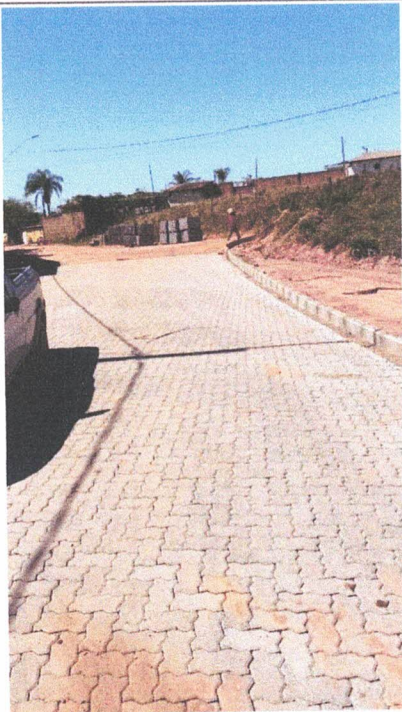
PAVIMENTAÇÃO EM PISO INTERTRAVADO
