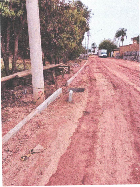
ASSENTAMENTO DE MEIO FIO
