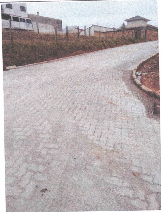
RUA SEBASTIAO PIRES RIBEIRO PAVIMENTAÇÃO CONCLUIDA
